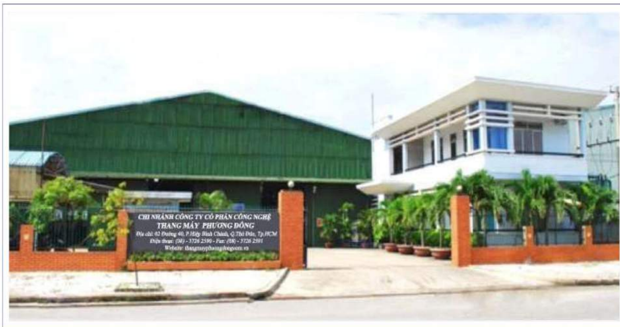
Nhà máy - Công ty CP CN Thang Máy Phương Đông
